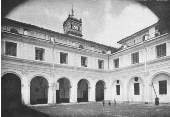
PATIO INTERIOR DEL PRIMER BLOQUE CONSTRUIDO (HACIA LA ACTUAL CALLE BENALCÁZAR). SE VE LA TORRE QUE MAS TARDE FUE DERROCADA LUEGO DE LAS AVERÍAS DEL TERREMOTO DE 1859
