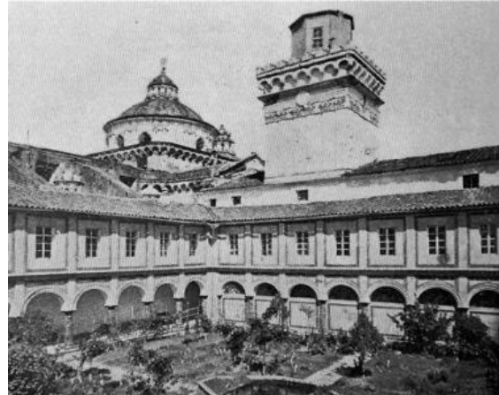
VISTA A LAS CUPULAS Y TORRE DE LA COMPAÑÍA DESDE EL PATIO SUR DEL EDIFICIO
